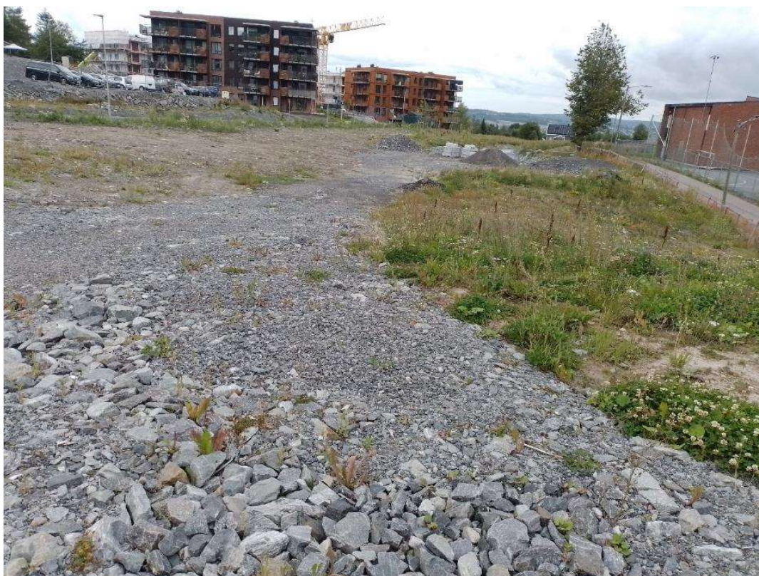
På motsatt side av Marikollen torg ved Fjerdingby den 6. august 2023 kl. 19.08. Utfylling, planering og nedbygging. Foto: Roald Bengtson.
